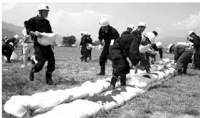
▲土のうを積み上げる消防団員や自主防災組織のメンバー
