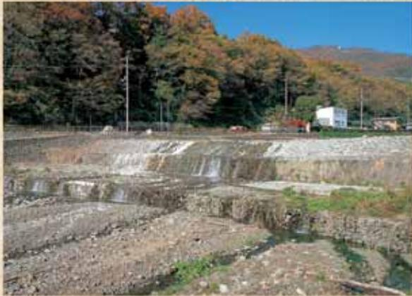
デ・レーヶは、明治6年（1873）に来日し、日本各地で河川の改修、砂防、築港の工事などを指導しました。この堰堤は、明治17年吉野川を調査したときに、支流から土砂が流出するのを防ぐため造られたもので、デ・レーヶが指導した砂防堰堤では最大級の規模といわれています。また、徳島県内で現存するデ・レーヶ指導の唯一の堰堤となりました。
