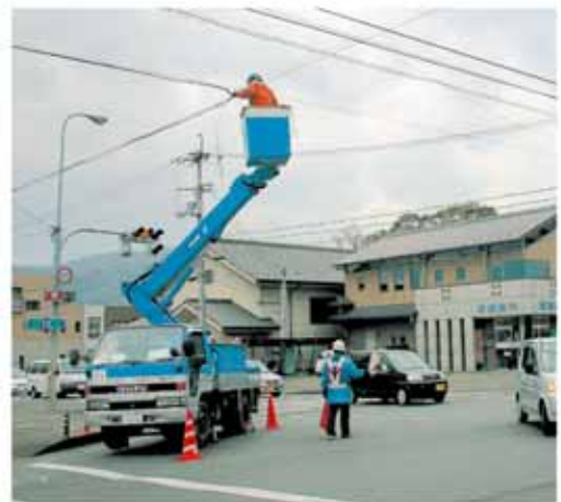
光ファイバー工事
