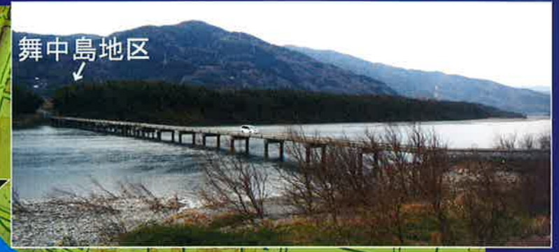
脇町潜水橋 もと「舞中島渡し」のあった場所付近に架橋されている。
