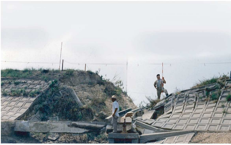
ため池堤体の決壊（市ノ池：兵庫県高砂市）
