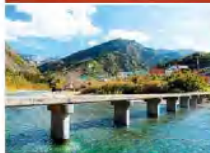
穴吹川潜水橋
