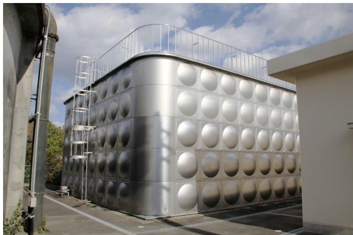
【脇町 西上野配水池】
