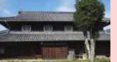
藍の生産を行った農家で、近代に建設業で栄えた青木家が、大正4年に隠居用として建築。約3590m<sup>2</sup>の敷地内に、主屋・納屋・土蔵などが建ち並ぶ。主屋は入母屋造り、大屋根の四方に庇をつけ、壁は鼠漆喰仕上げの堂々とした建物。
