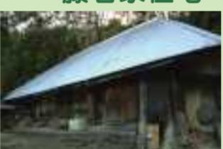
讃岐山脈南麓に建っている、寄棟造り茅葺きの民家。屋根は現在鉄板で覆われている。棟札が残されており、元禄13年(1700)年の建築である。
