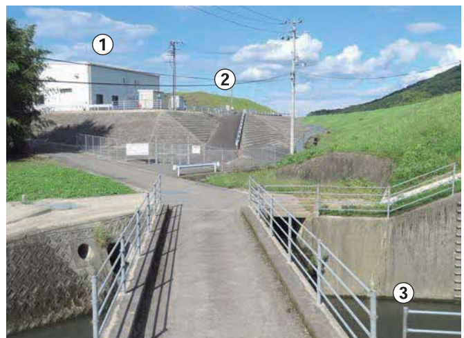
拝原最終処分場 ①浸出水処理施設 ②廃棄物最終埋立処分場 ③処理水が放流される土井谷川
