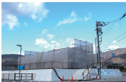
建設中の美馬アグリワーケーション施設 (令和4年12月撮影)
