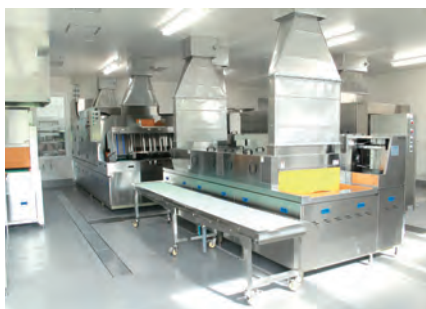
新学校給食センター内部
