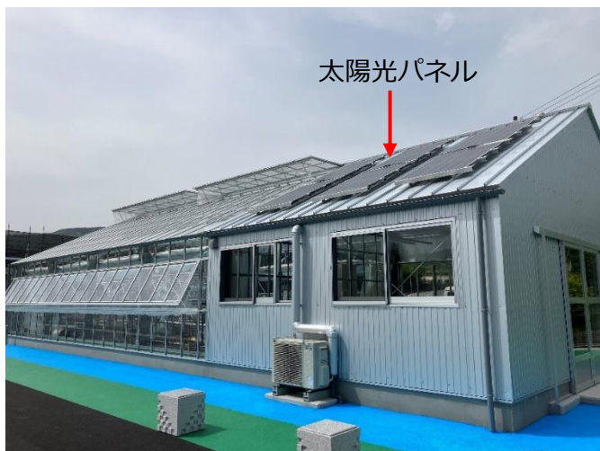
▶ 太陽光パネル
