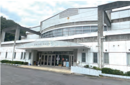
大規模改修予定の 穴吹スポーツセンター
