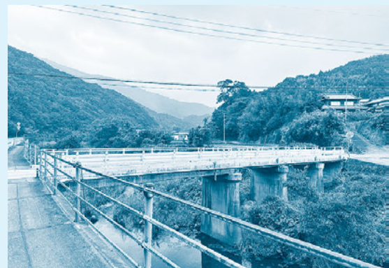
▲修繕した橋梁(宮井橋)
