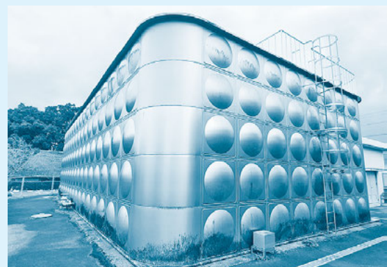
▲脇町西上野配水池
