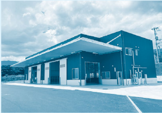
▲「公助」総合防災倉庫
