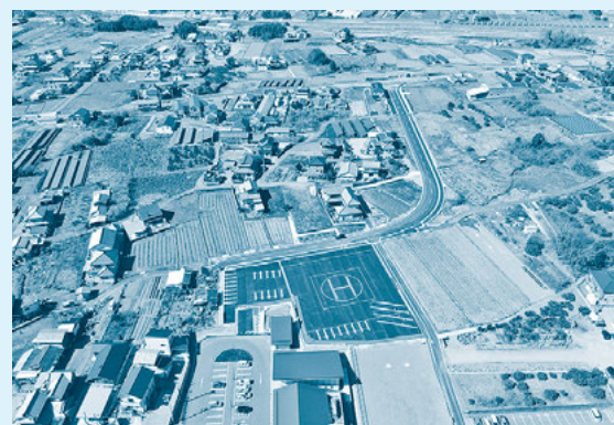
▲道路新設工事（美馬 652 号線）
