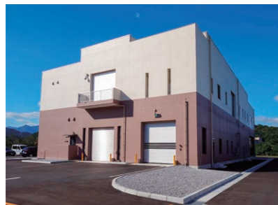
▲汚泥再生処理センター
