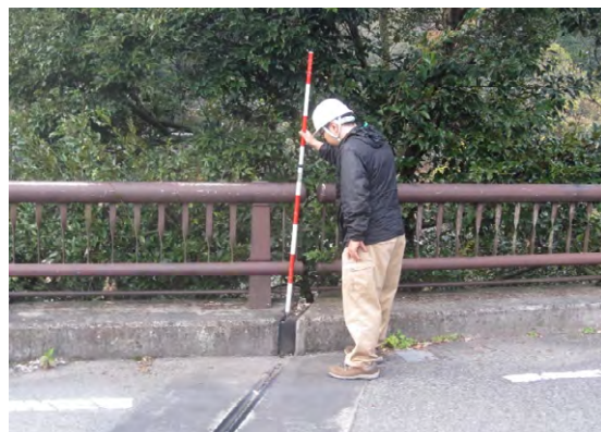
日常パトロールの状況
